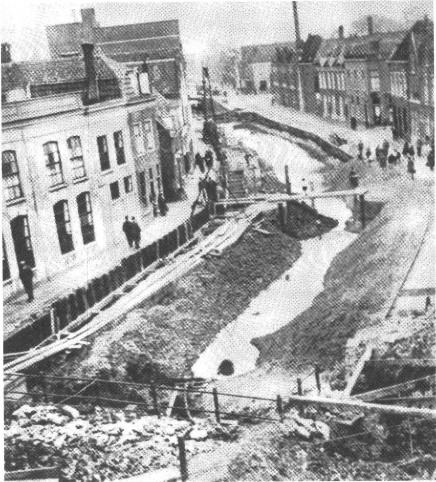
De demping van het Levendaal, werkverschaffingsproject 1934-1936 (Gemeentearchief Leiden, pv.nr. 5493.33).
