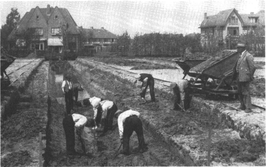
De aanleg van de Leidse Hout, werkverschaffingsproject 1930-1931 (Gemeentearchief Leiden, BLO 3800/32.9).
