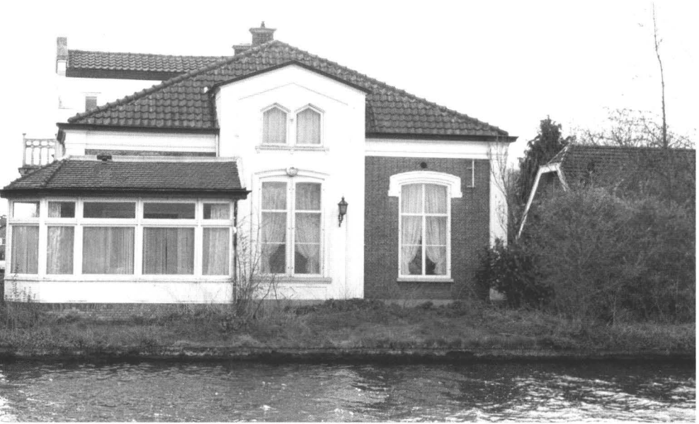
De villa van de directeur op het terrein van Nieuw Werklust.
