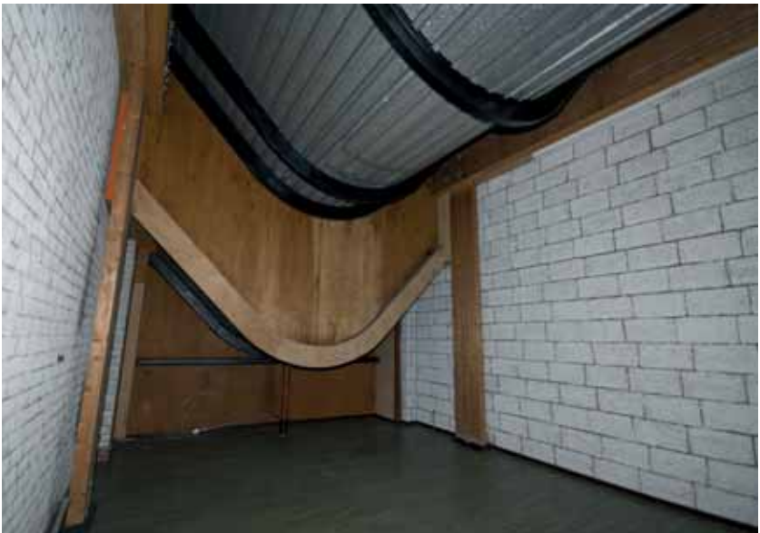
Boven: Vergaderruimte op de derde verdieping met een opeenvolging van de naar binnen bollende daken. Onder: De constructie van het dak is zichtbaar gelaten in een bergruimte op de derde verdieping.
