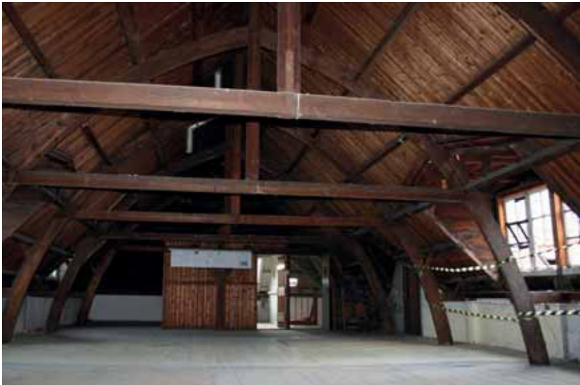
Philiberspanten uit 1852 op de zolder van het voormalig Evangelisch-Luthers Wees- en Oudeliedenhuis. Foto Francien van Zaanen Durand, ELO.
