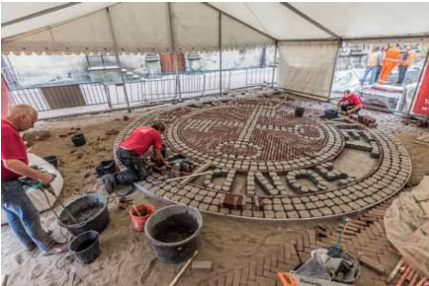
Straatmakers maken een medaillon in de Breestraat ter hoogte van het stadhuis. Foto Hielco Kuipers.
