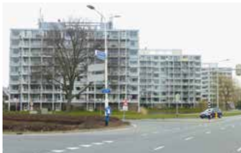
De drie appartementencomplexen aan de Jacob van Campenlaan, gesitueerd op evenwijdige en regelmatige afstand van elkaar, met uitkragende balkons op dragende kolommen. Foto Peter Lamboo, 2018.
