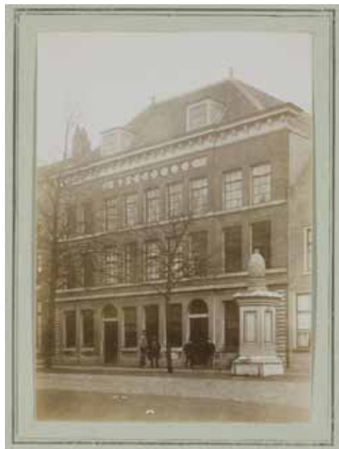
Het fabriekspand van Le Poole aan de Garenmarkt. Foto ca. 1900. Erfgoed Leiden en Omstreken.
