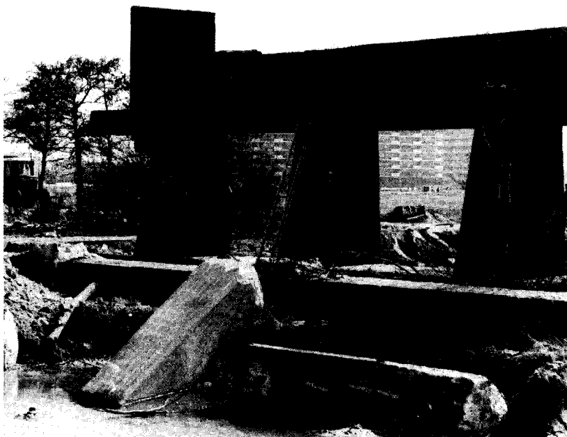
afb. 9. Nu afgebroken fundering aan de Haagse Schouwweg tbv. de voormalige Rijksweg 4B. Foto Holvast, 1976.
