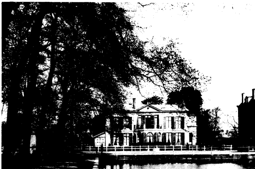
afb. 2. Rijnsoever bij de Boshuizersluis, afgebroken in 1897. Foto J. Goedeljee.
