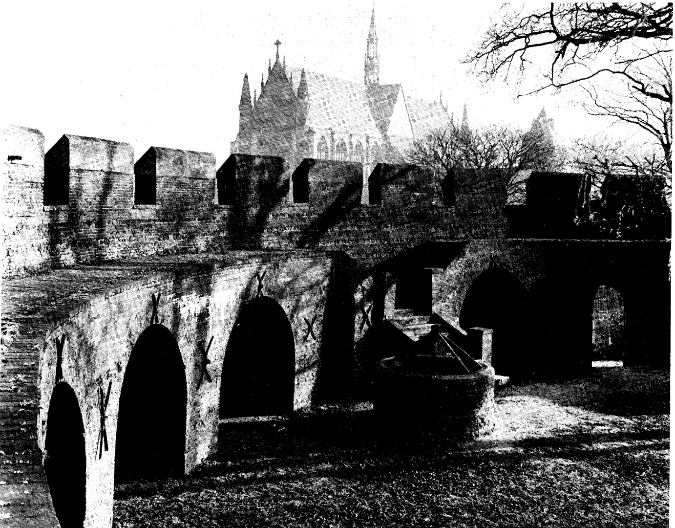
33. Burcht, binnenzijde voor de restauratie
