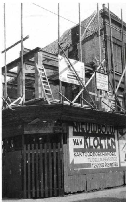
Het pand in aanbouw. Foto H. Lamberts. Coll. Monumentenzorg Leiden.
