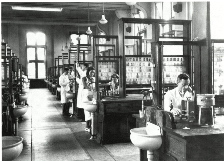
Interieur van de Grote Werkzaal op de eerste verdieping, gezien naar de achterzijde, omstreeks 1949. B.A. van Mourik, Universitas Leidensis (Leiden 1949) 80.
