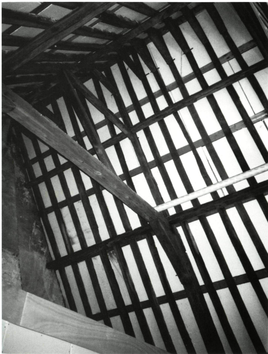
De kapconstructie in Rapenburg 43.
