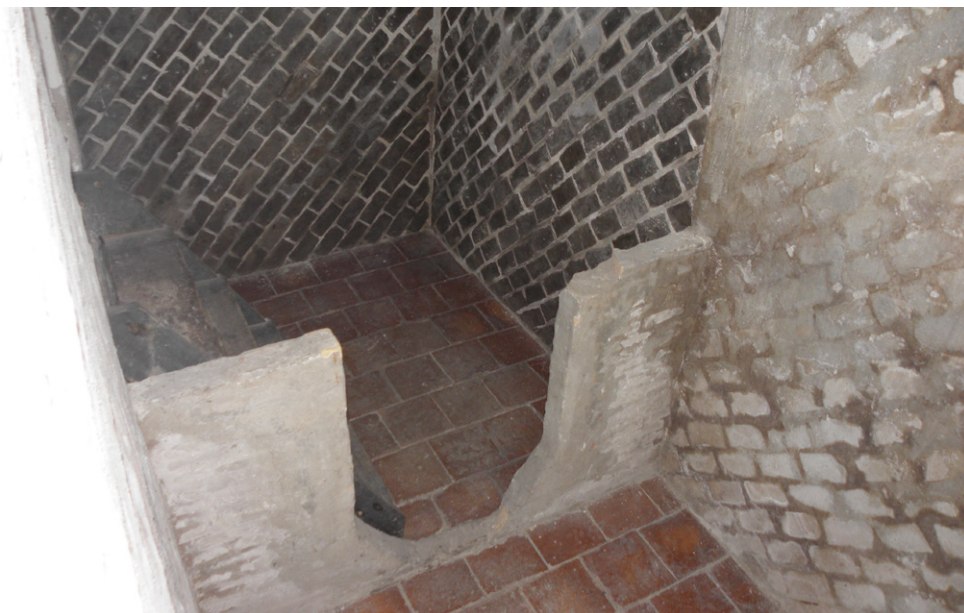
De aloude kelder met een nu doorgebroken schot dat de kelder deelt; een zogenaamd bezinkbassin en een deel voor helder water.
