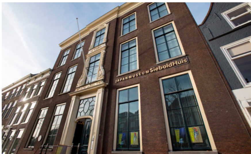
Gevel Japanmuseum SieboldHuis, Rapenburg 19 Leiden Fotograaf: Marc de Haan
