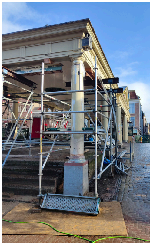
Rechts: De nieuwe funderingskolom tijdens het terugplaatsen van basement en kolomvoet.
